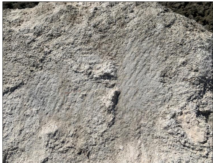
Fig. 9. Detalle de las estrías con restos de argamasa, producto de su reutilización como elemento constructivo.
