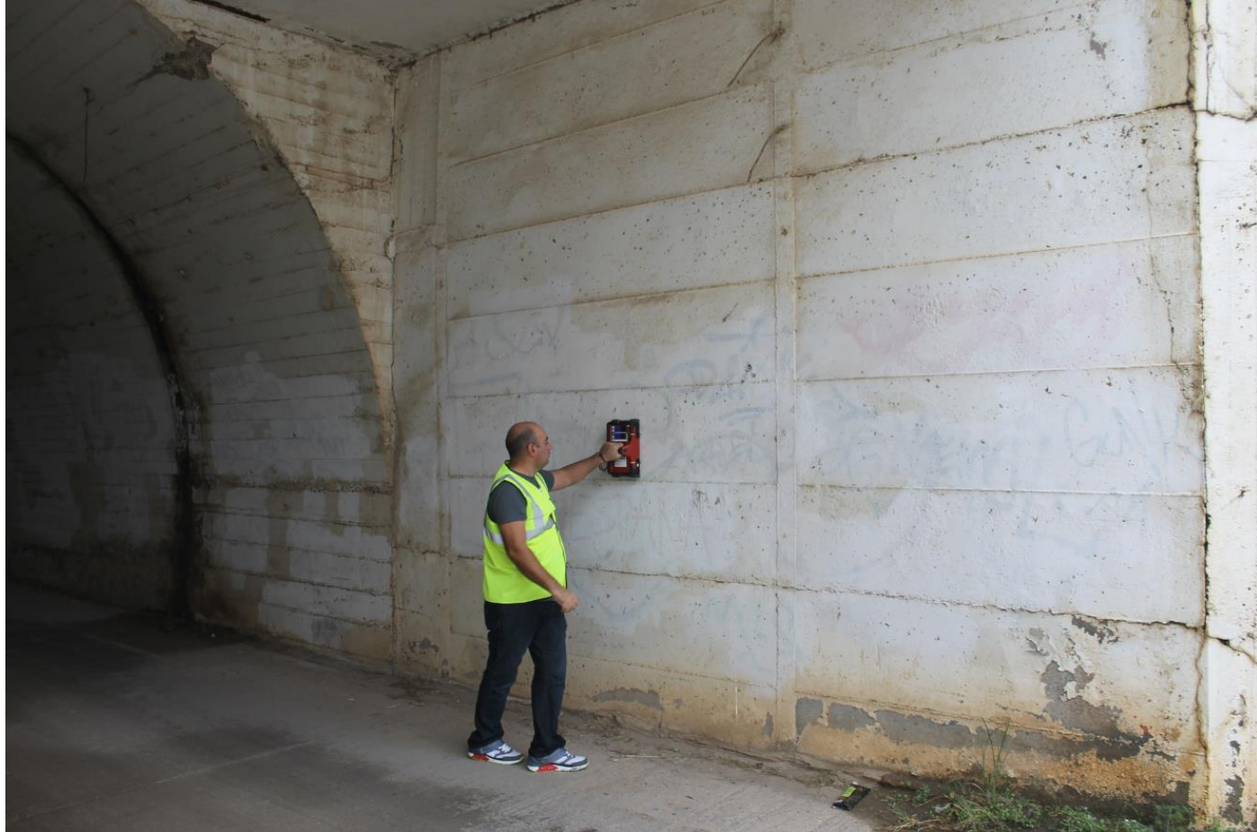
Escaneo de armado en paso inferior (de carretera)
