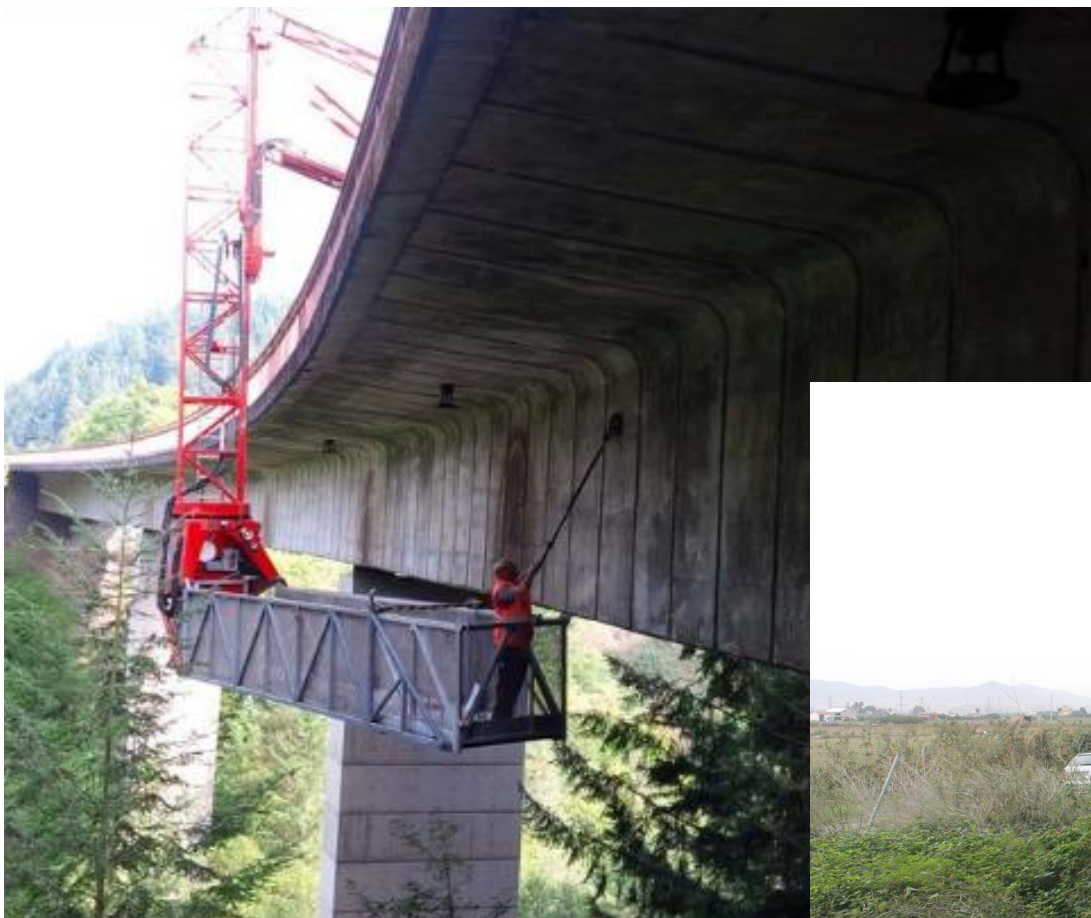
Escaneo de elementos en puentes
