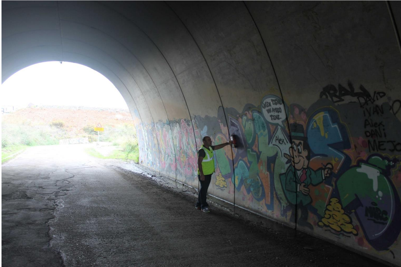
Verificación de recubrimientos en bóveda prefabricada
