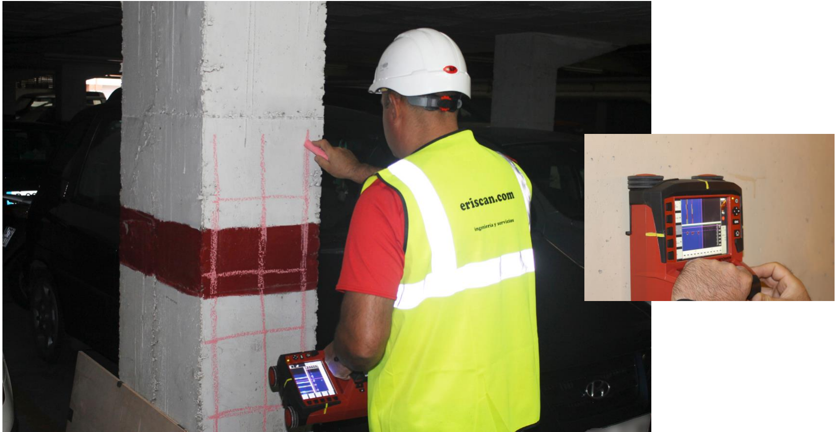
Visualización y marcaje de armado en pilar
