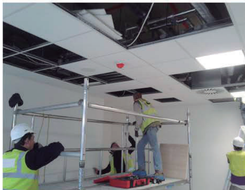
Mantenimiento preventivo de anclajes
